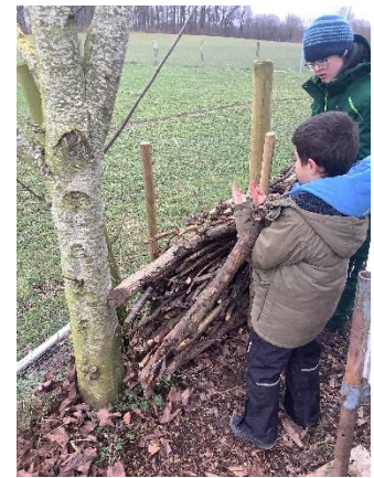
Bau eines Totholzzauns
