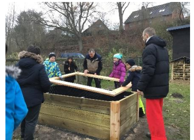
Beim Bau eines Hochbeets
